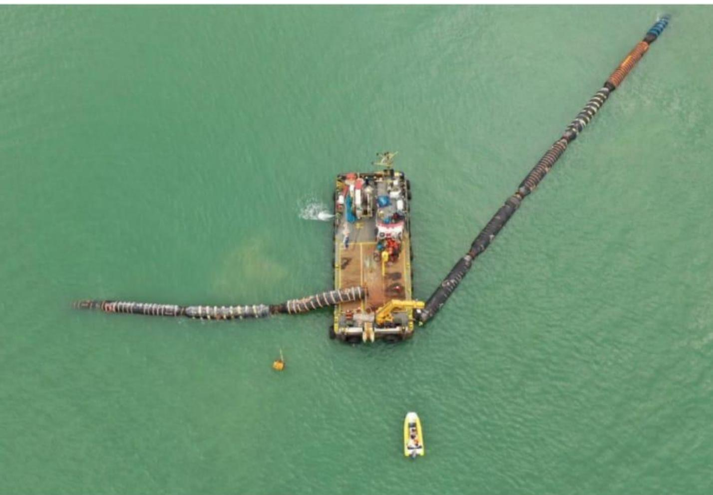
Finalizada a montagem, o duto é colocado mais próximo da água durante a maré baixa. Quando a maré encher, uma das extremidades da Linha de Recalque será içada por um rebocador e levada para alto mar – enquanto a outra extremidade permanece na praia. Essa é uma das etapas mais sensíveis e que requer mais atenção.
