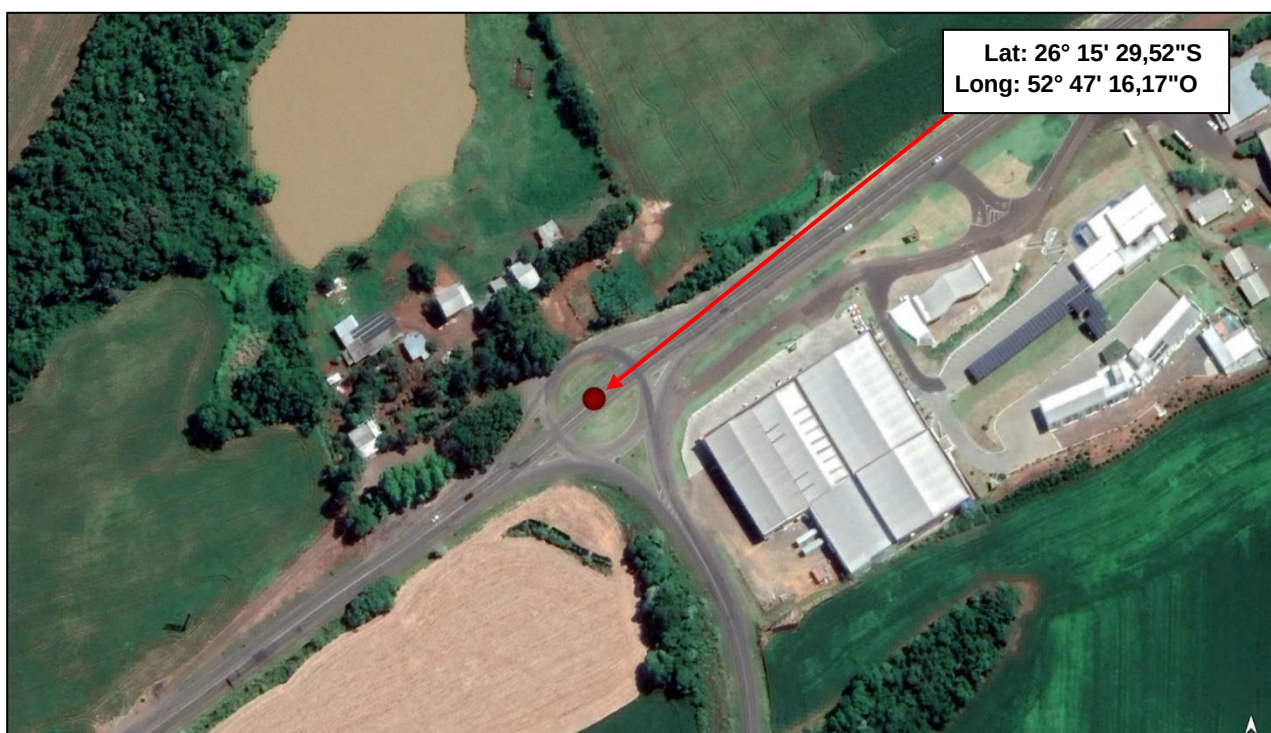
Figura 15 – Fim do Segmento no entroncamento com a PR-280/PR-158 (Vitorino)
