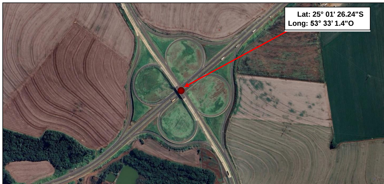
Figura 3 – Fim do Segmento no entroncamento com a BR-277/PR
